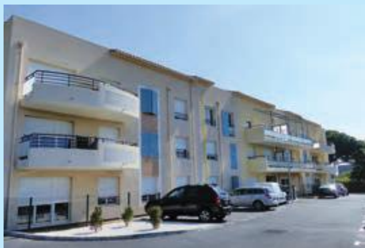
Une première tranche livrée en Mars 2017 – 31 Logements
